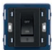
19018 45 A, ON/OFF. Profundidad: 22,5 mm
