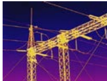
Inspección de servicios públicos
